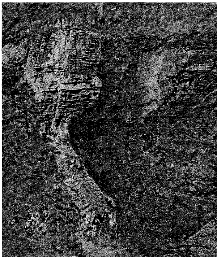
SOMMET EFFONDRE DE LA SORTIE DU GUIERS-VIF
